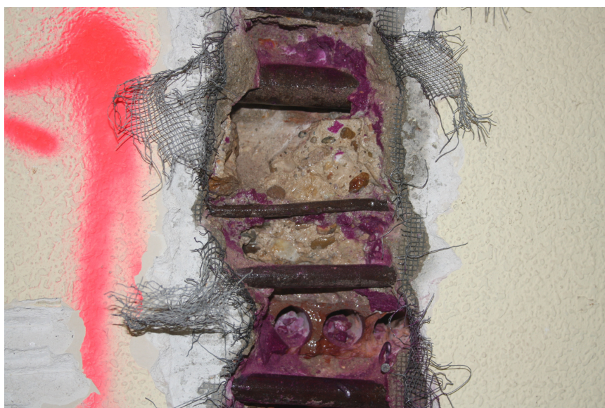
Calicata abierta y "test de fenolftaleína"
