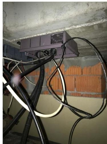
Fig. 16 Entrada de cables a VIVA
