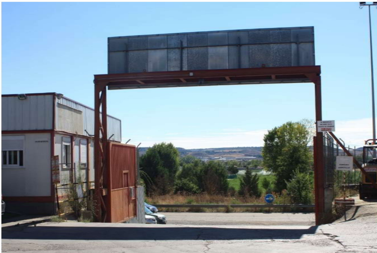
Acceso a la parcela (plataforma 4) desde la carretera de Burgos-Portugal km 119A (Valladolid)
