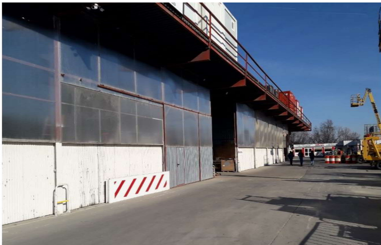
Edificio 05 (marquesina para talleres) y zonas de almacenaje exteriores en plataforma 4
