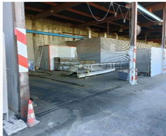
Pintura y limpieza de encofrados
