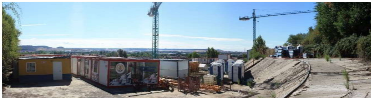
Zona de almacenaje exterior en plataformas 3 (superior) y plataforma 5 (inferior)
