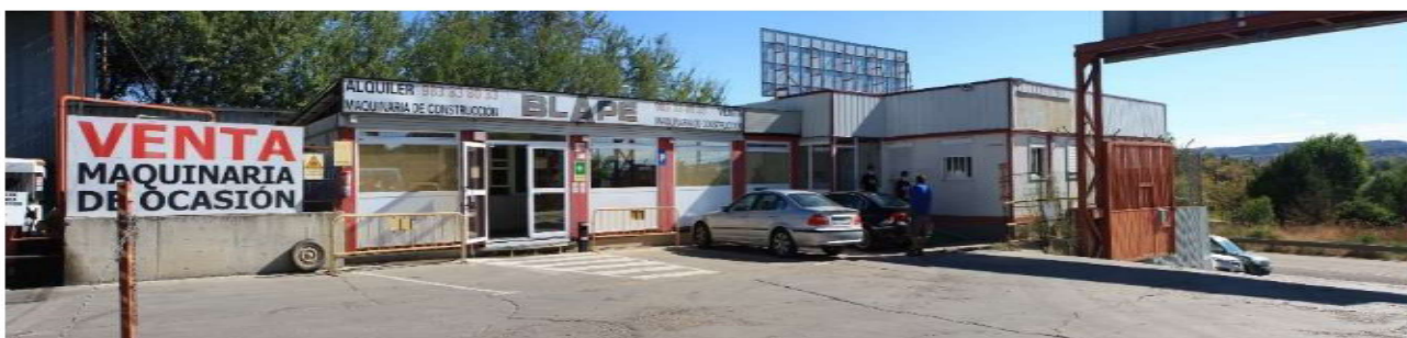
Acceso a la parcela, edificio 01 (administración y oficinas) y depósito de gasóleo B
