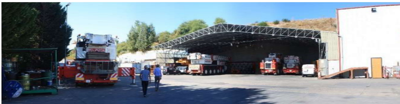
Edificio 10 (marquesina para almacenaje de maquinaria) en plataforma 1
