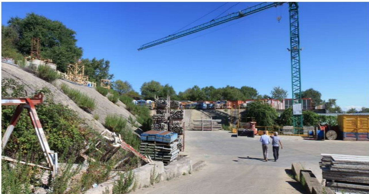
Rampa y zona de almacenaje exterior en plataforma 2
