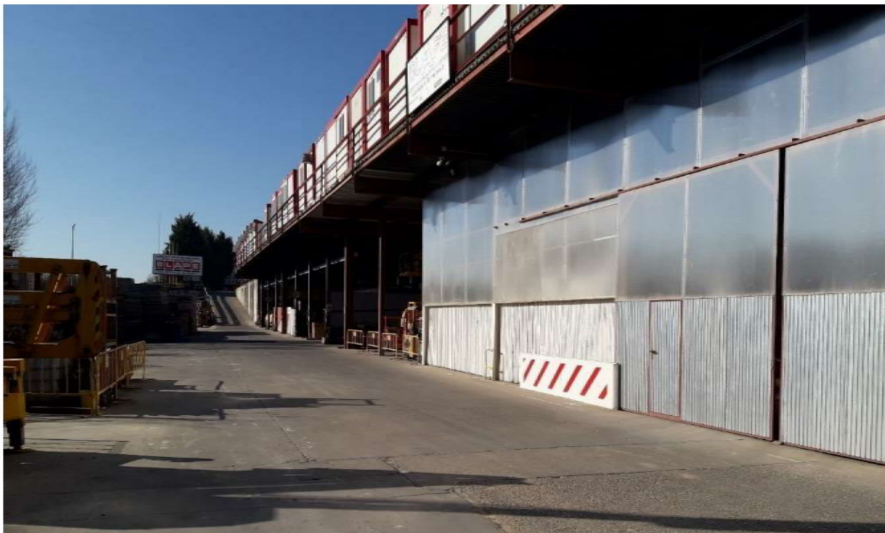
Edificio 05 (marquesina para talleres) y zonas de almacenaje exteriores en plataforma 4
