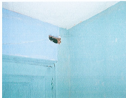
HALL DE ENTRADA: CAJA DE DISTRIBUCIÓN Y BOQUETE EN LA PARED
