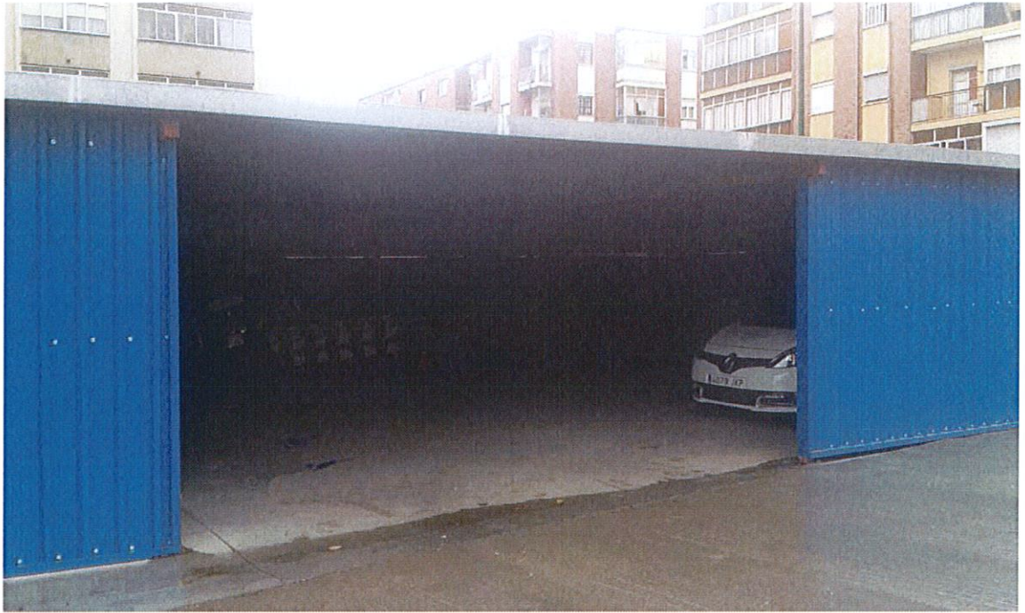
Zona de acceso. A instalar nuevo portón y canaleta
