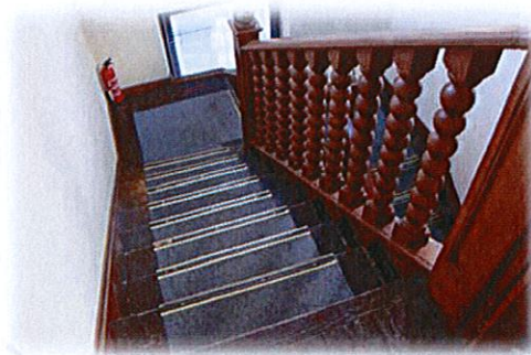
Vista desde planta torre
