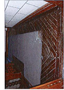
F02 Estado actual descansillo
