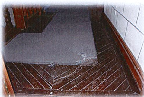
Vista distribuidor Pta. Primera Tarima a Sustituir
