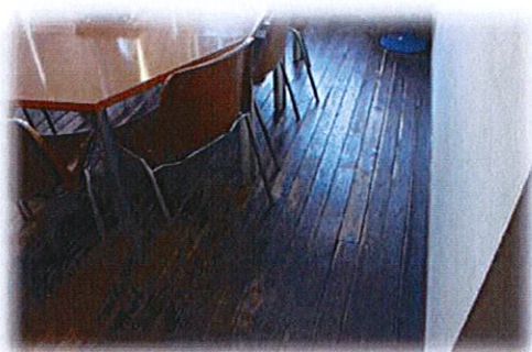
Vista Sala Descanso (Pta. Torre) Tarima a Sustituir
