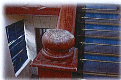
Viste remate circular de pilastras Lijar y pintar a "la pluma"
