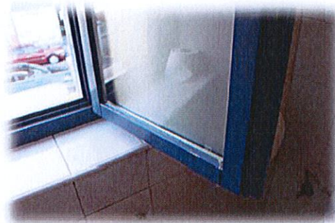
Aspecto ventana aseada. Primera SIN VIERTEAGUAS INSTALADO Menor incidencia y estado de conservación óptimo
