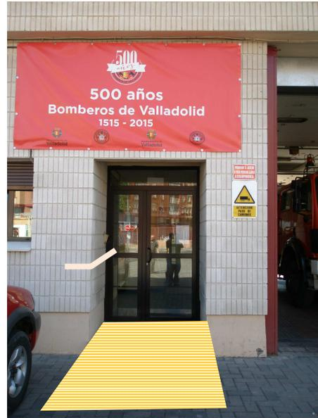
Para ello se demolerá la pequeña meseta frente a la puerta de acceso peatonal y se sustituirá por una pequeña rampa del 10% de pendiente máx. que se solará con gres antideslizante y contará con pasamanos de tubo de acero inoxidable de Ø 50 colocado en el lateral izquierdo, adosado a la fachada y a 1,00 m de altura.
