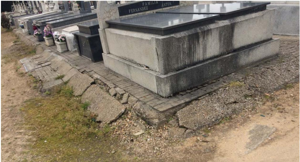
Cuadro 59. Borde en mal estado. Rotura, desprendimientos, ausencia de remate de borde.
