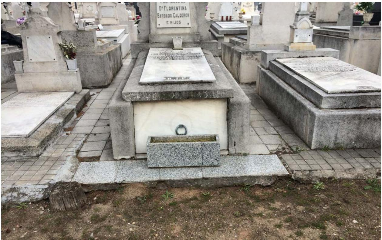
Cuadro 54. Pavimento con hundimientos. Diferentes pavimentos en una misma zona.
