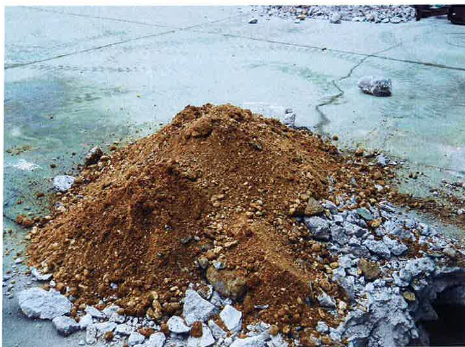
CALICATA C-1. MATERIAL EXTRAIDO.
