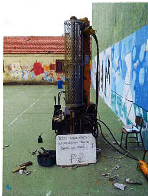
ENSAYO DE PENETRACION DINAMICA TIPO D.P.S.H. Nº 2.
