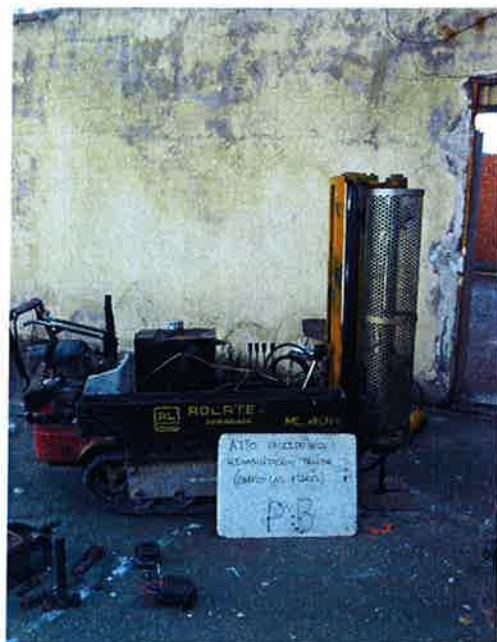
ENSAYO DE PENETRACION DINAMICA TIPO D.P.S.H. Nº 3.
