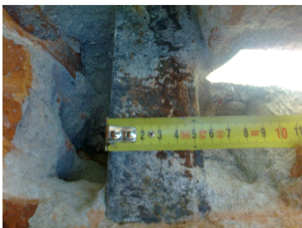
Identificación de UPN-120 con un ala de 55mm
