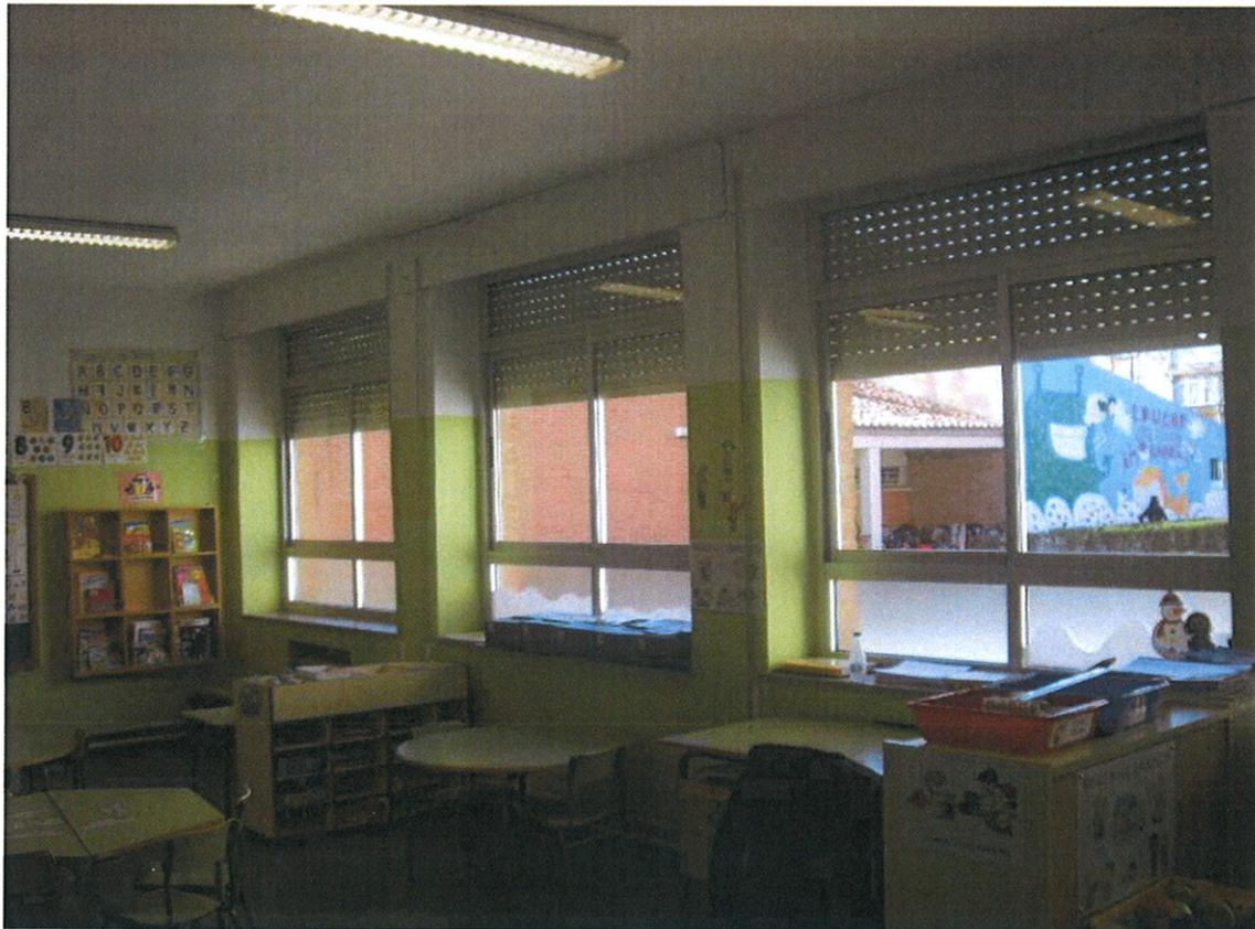
VIDRIO CLIMALIT 4/16/4 TRASLÚCIDO. EN LA PARTE SUP. VIDRIO SEGURIDAD TRASLÚCIDO. 4+4/12/4 EN LA PARTE INFERIOR
