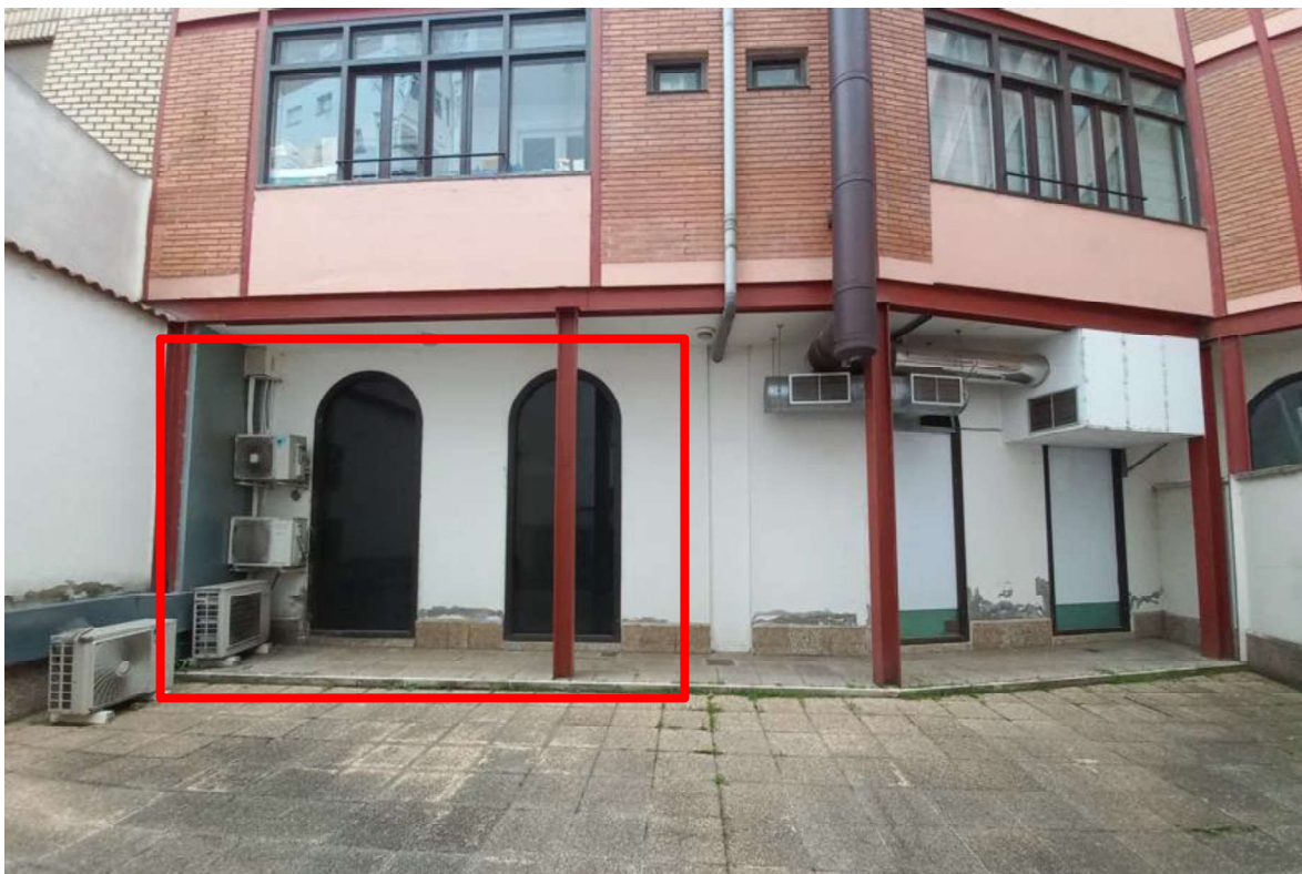
Vista de la fachada al patio posterior
