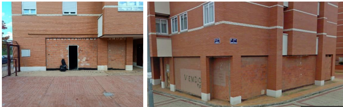
Figura 1. Situación y vista de las 3 fachadas actuales del local.
