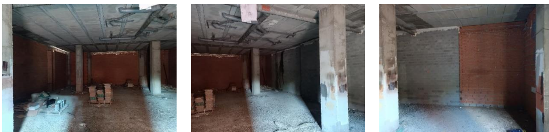
Figura 2. Sistemas constructivos actuales existentes en el local objeto de estudio.
