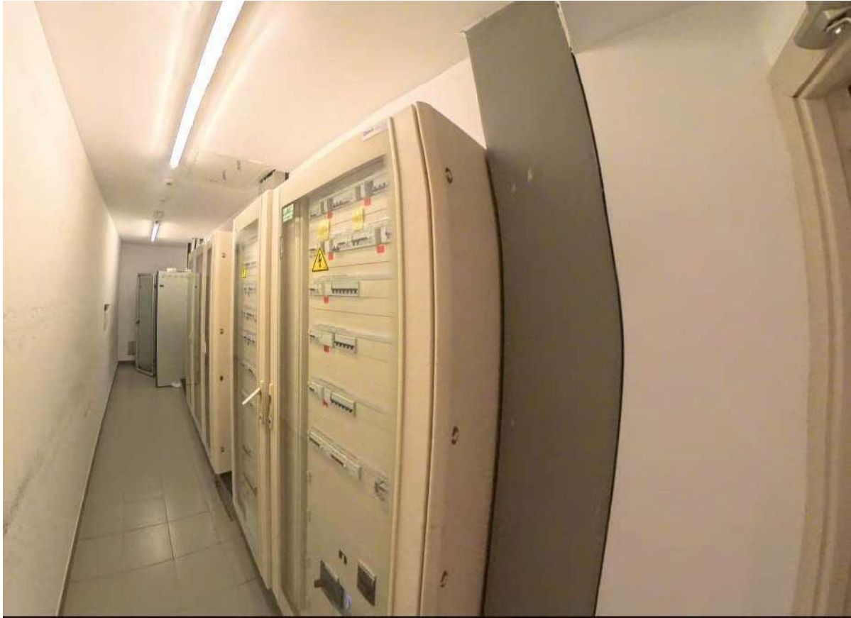
Estado original planta baja previo a inicio de fase I
