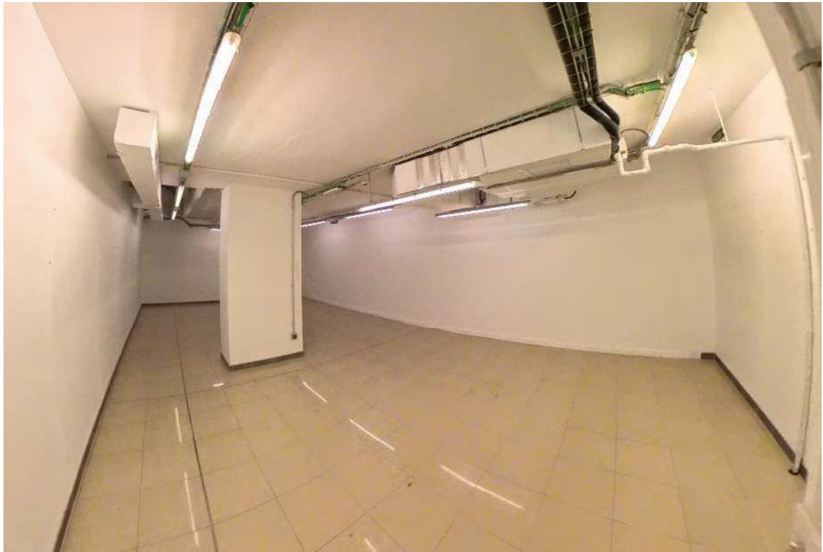
Interior: estado original planta sótano previo a inicio de fase I
