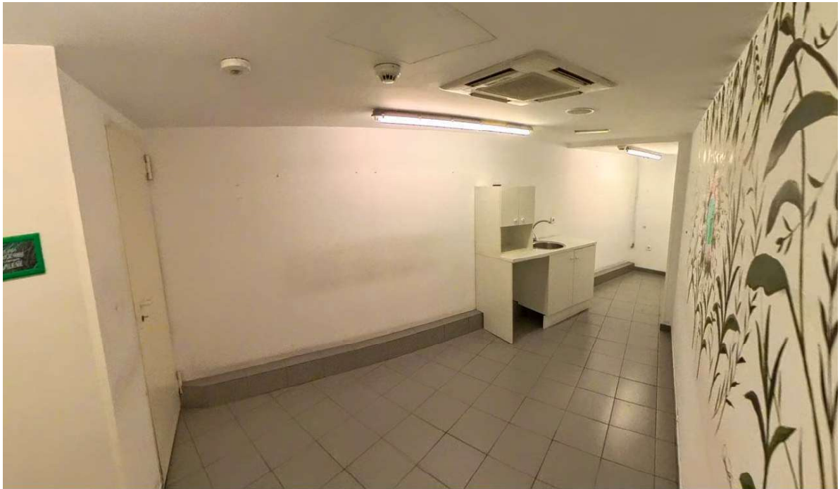
Interior: estado original planta sótano previo a inicio de fase I
