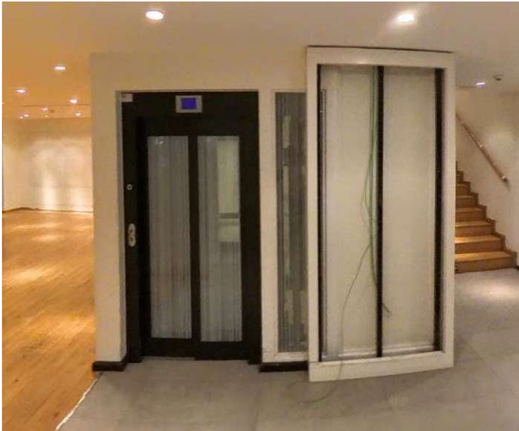
Estado original planta baja previo a inicio de fase I
