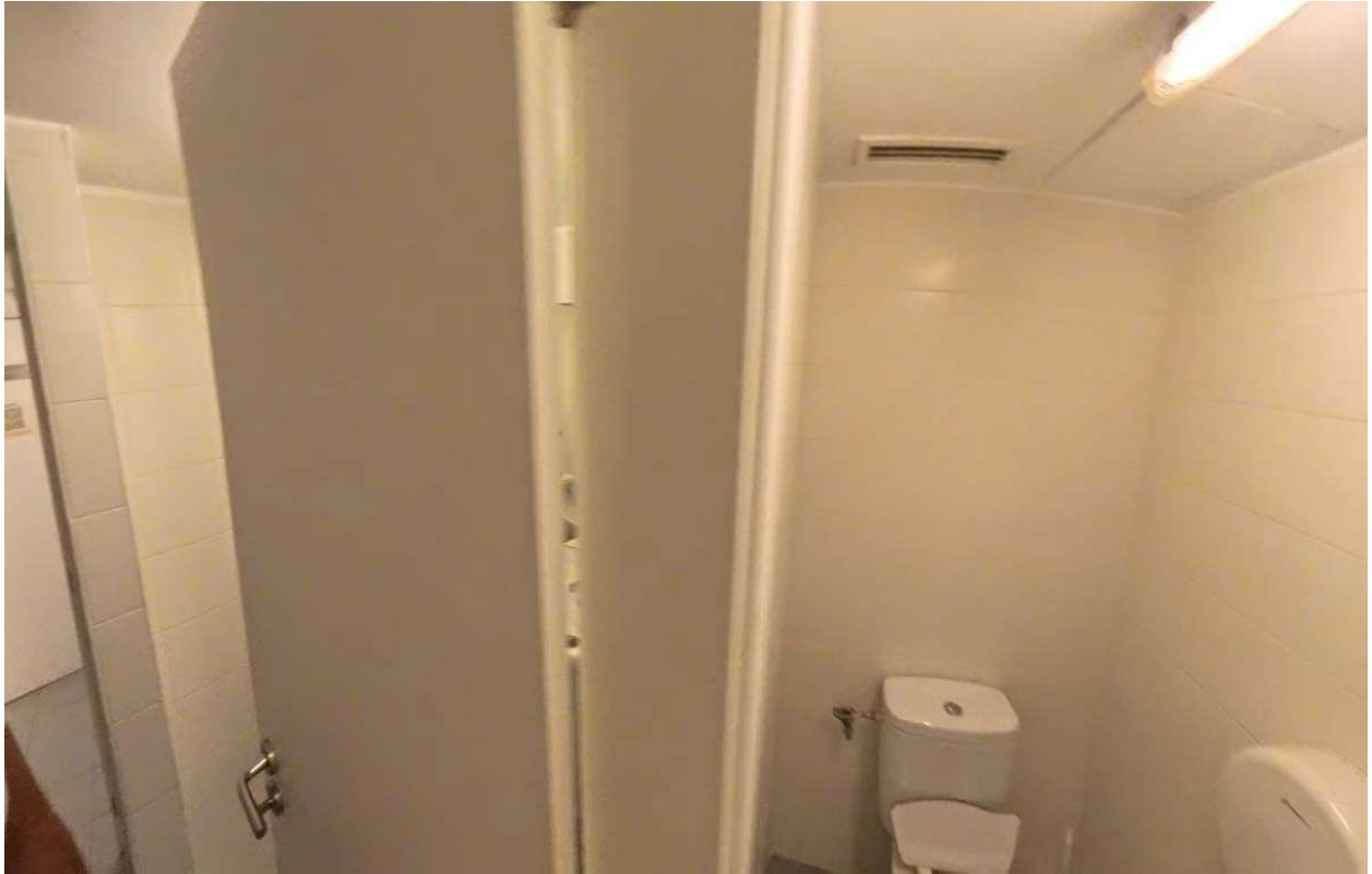
Interior: estado original planta primera previo a inicio de fase I
