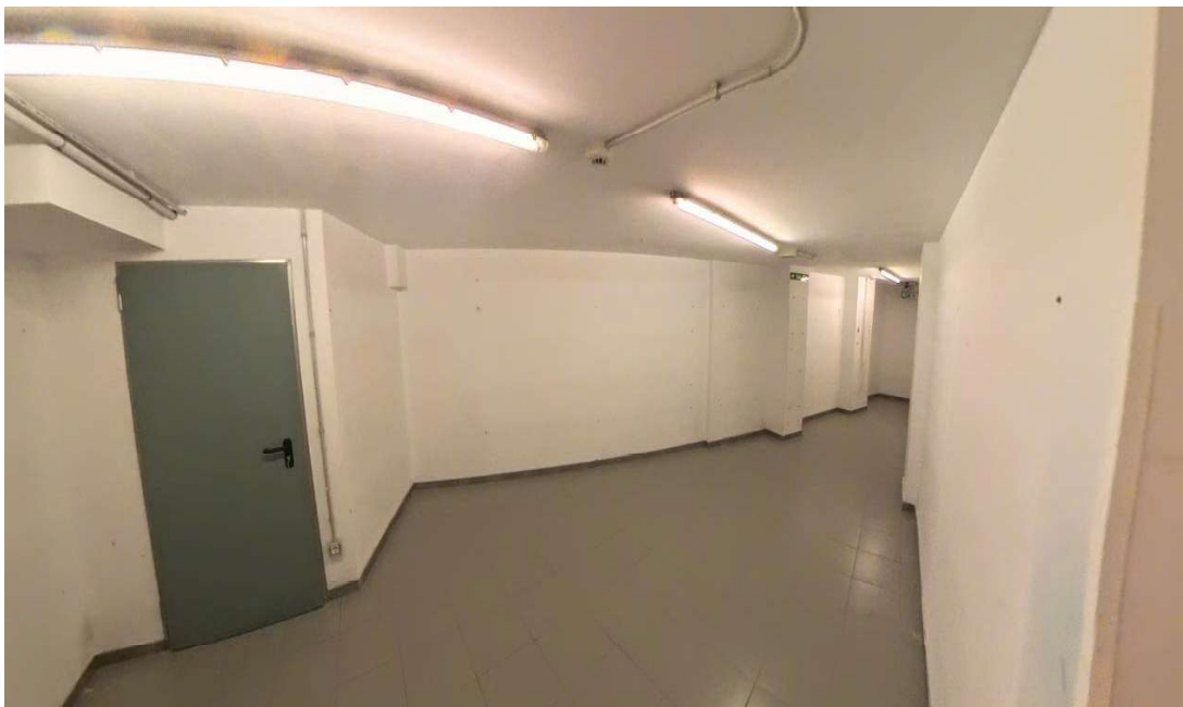
Estado original planta baja previo a inicio de fase I
