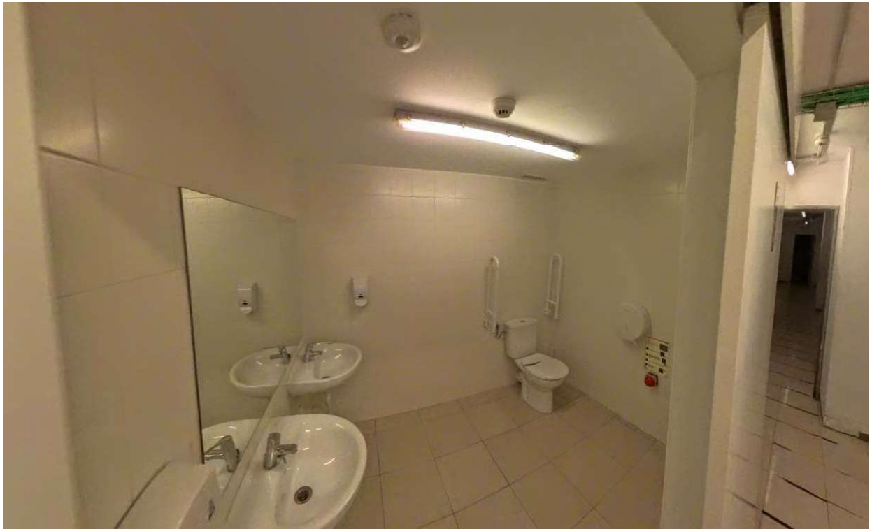
Interior: estado original planta sótano previo a inicio de fase I
