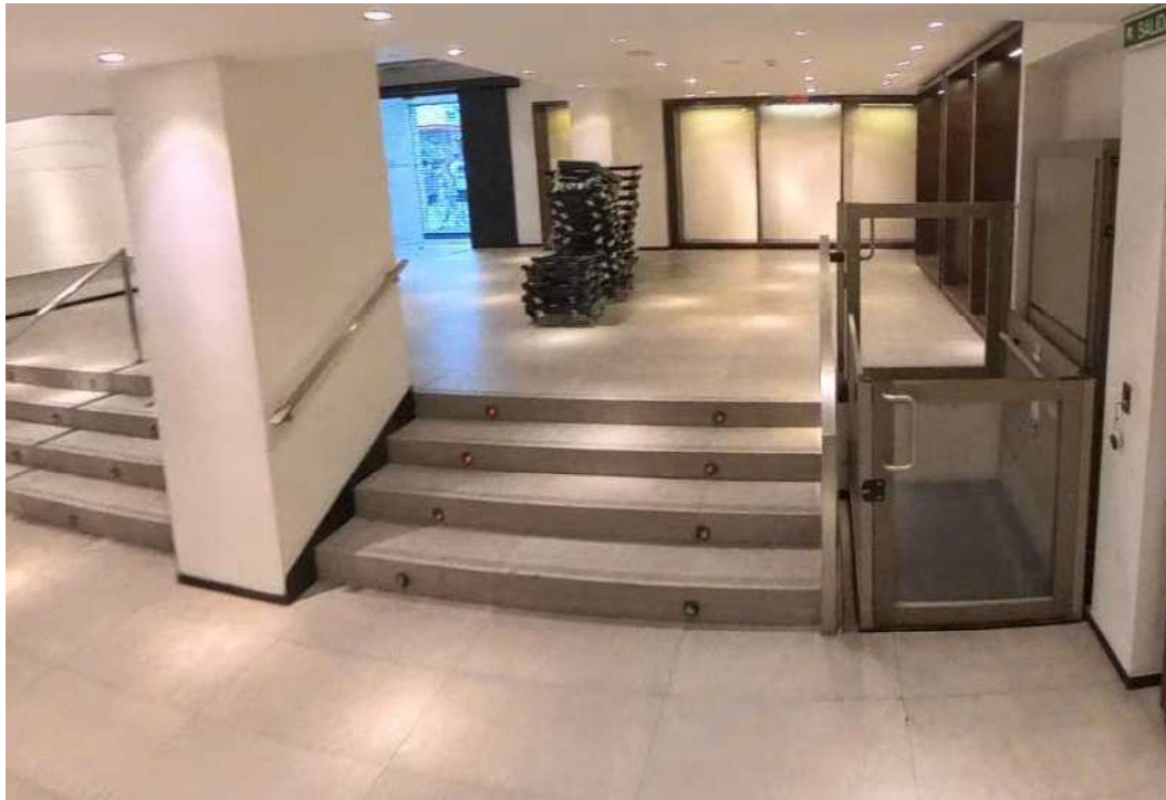
Estado original planta baja previo a inicio de fase I
