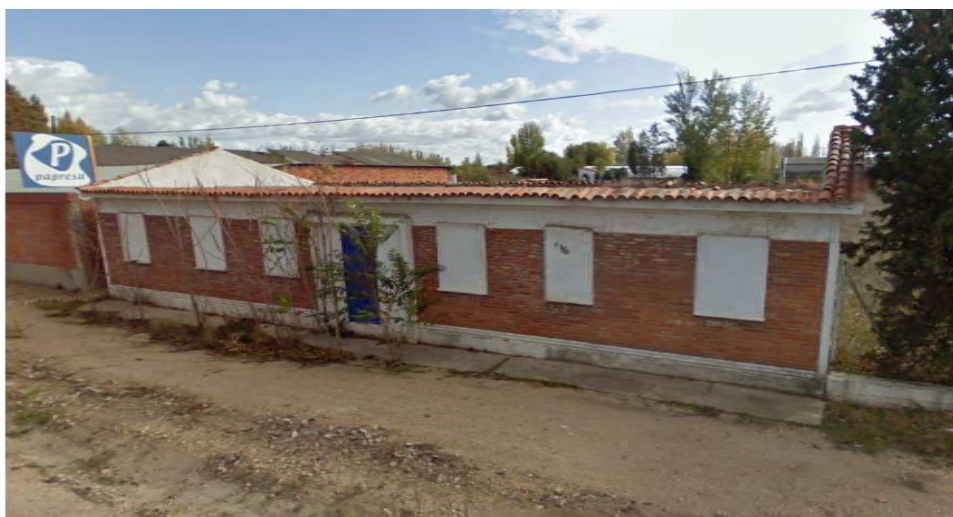
Acera existente en el frente de la vivienda 2 hacia el Camino Viejo de Simancas (noviembre 2009)
