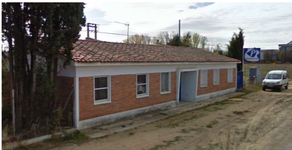
Acera existente en el frente de la vivienda 1 hacia el Camino Viejo de Simancas (noviembre 2009)
