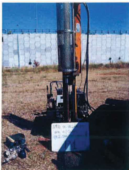
ENSAYO DE PENETRACION DINAMICA TIPO D.P.S.H. N° 1.
