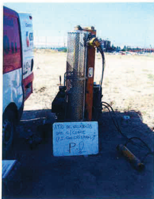
ENSAYO DE PENETRACION DINAMICA TIPO D.P.S.H. N° 2.
