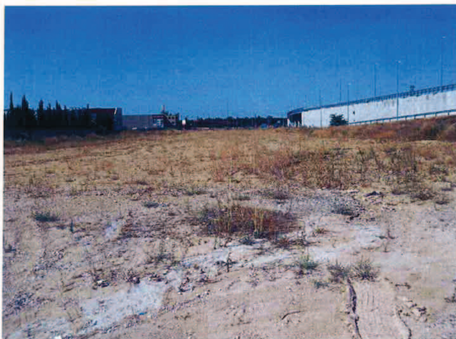
VISTA DE LA ZONA DE CONSTRUCCION DE LA NUEVA CALLE DESDE EL NORESTE
