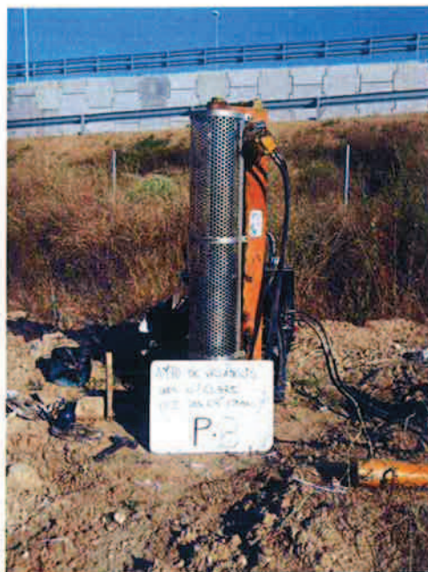
ENSAYO DE PENETRACION DINAMICA TIPO D.P.S.H. N° 3.
