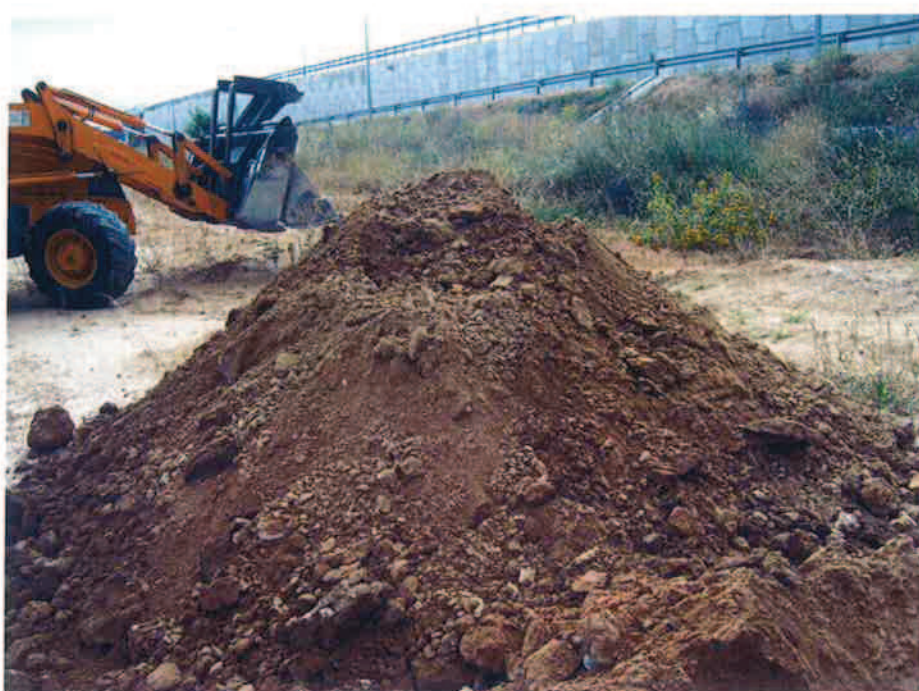
CALICATA C-3. MATERIAL EXTRAIDO.
