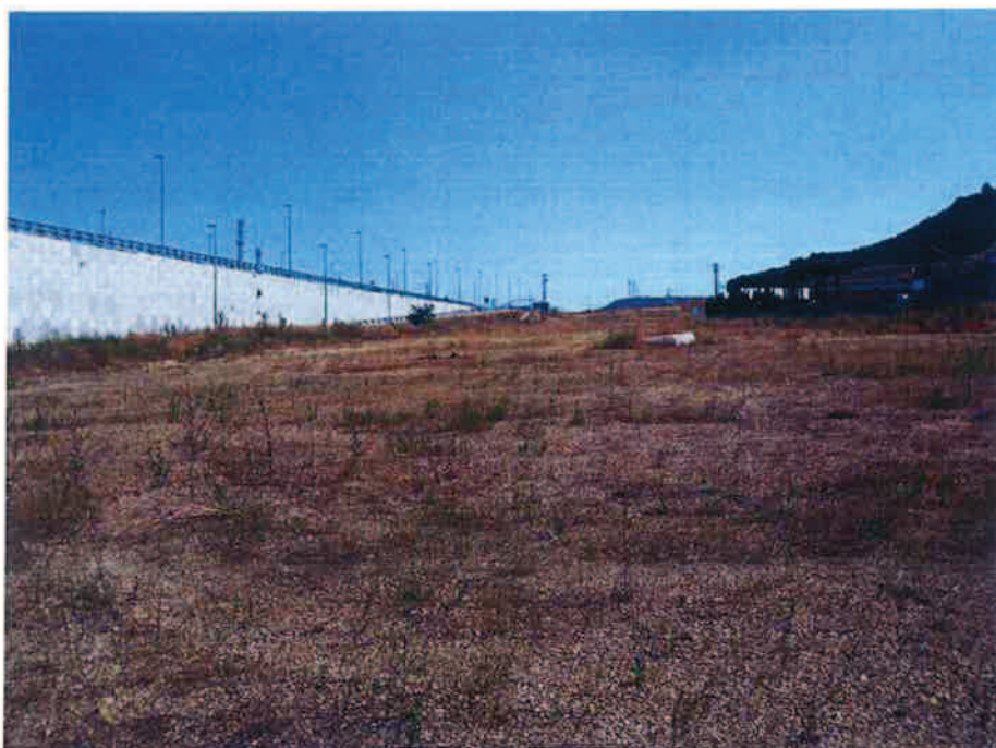
VISTA DE LA ZONA DE CONSTRUCCION DE LA NUEVA CALLE DESDE EL SUROESTE
