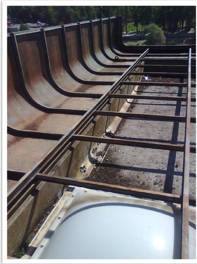
Imagen 4: estado de la cubierta, con la impermeabilización prácticamente desaparecida.
