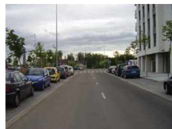
Dos calles del PERI Ariza-Ciudad de la Comunicación.
