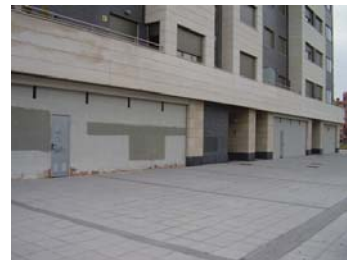
Bajos comerciales sin ocupar en la zona del PERI de Ariza-Ciudad de la Comunicación.
