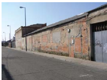
Naves abandonadas en la zona norte del polígono, junto a las vías del ferrocarril Valladolid-Ariza.
